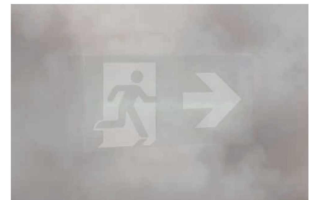
Schlecht beleuchtetes Rettungszeichen
