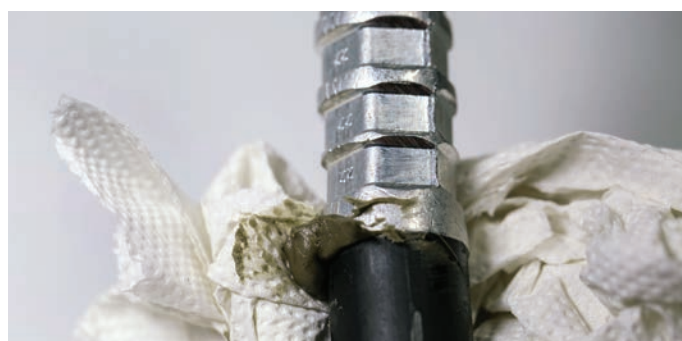
Bild 8: 1. Isolation entfernen, 2. Leiter reinigen, 3. Leiter einführen, 4. Sechskant Verpressung, 5. Kontaktfett entfernen
