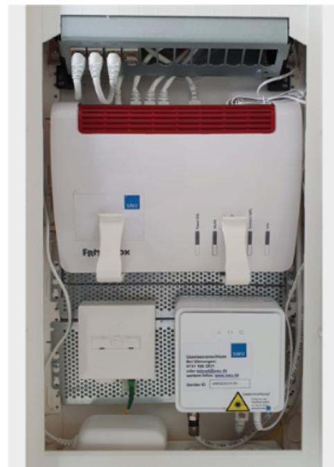
Abbildung 4: Multimediaverteiler bestückt
