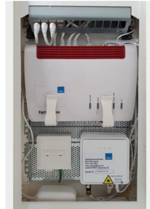
Abbildung 4: Multimediaver teiler bestückt (Quelle: Fa. Hager)
