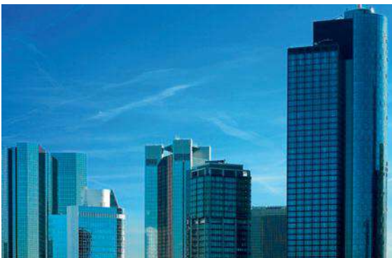
Bürogebäude / Office buildings
