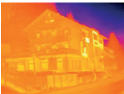
Wärmebild ohne testo ScaleAssist
