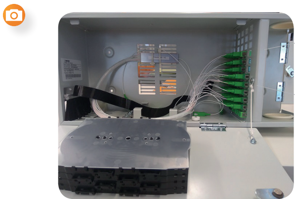
SC/APC Anschlüsse werden in vielen Montageschränken eingesetzt (Haupt-oder Verteilerschränke und Zugangspunkt beim Teilnehmer).
