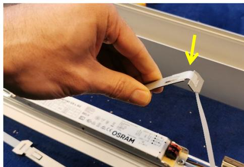
Blechhalter der Montagehilfe biegen (Kunststoffband läuft über die Biegung!)
