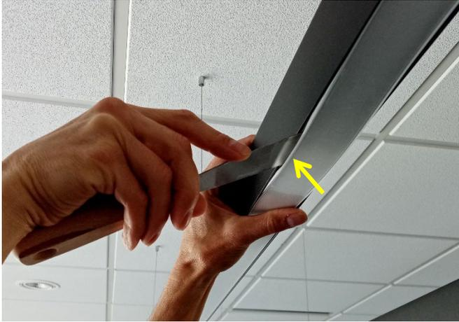
Spachtel zwischen Kanalwandung und Abdeckung einstecken. Spachtel als Hebel benutzen und Abdeckung aus der Nut heben. Vorsicht: Gummisteg nicht beschädigen
