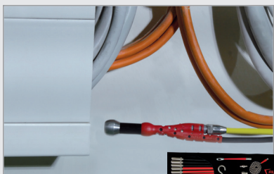
Jaški in kanali pod tlemi
