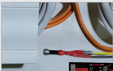
Szachty i kanały podpodłogowe
