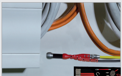
Schächte und Unterflurkanäle
