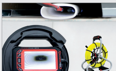
Inspekcija ventilacije i održavanje
