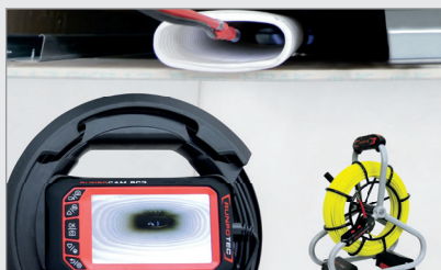
Tuuletuksen ja kunnossapidon tarkastukset
