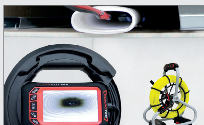
Inspekce větrací trubek a při údržbě
