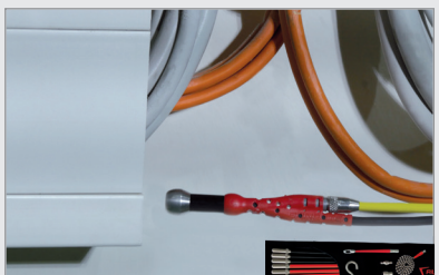
Šahtovi i podni kanali
