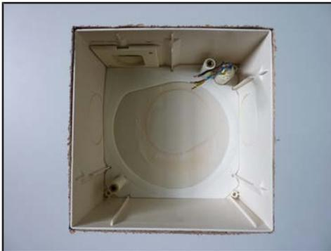
3. Legen Sie die im Lieferumfang enthaltene Dichtung am Gehäuseboden ein. Beachten Sie dabei die Führungskanten der Dichtung.
