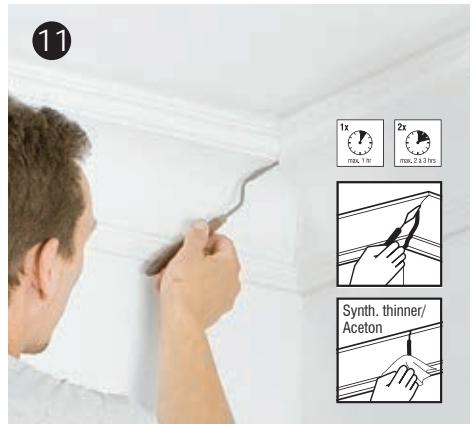
Überschüssigen Kleber vor dem Aushärten mit einer Spachtel entfernen durch Abziehen (nach 1 Std und nach 2-3 Std wiederholen)
