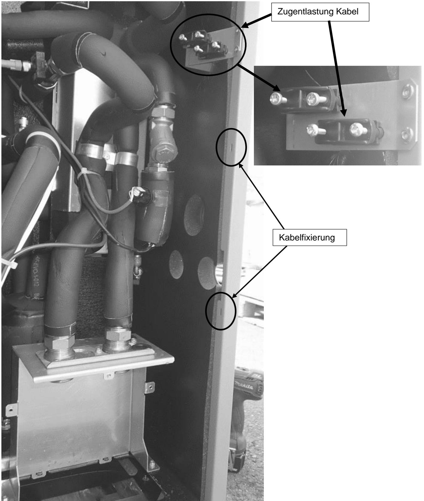
**10 Abdeckblech nach hydraulischem Anschluss und
